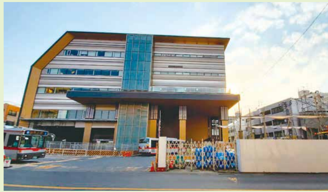
交番の取り壊し工事中
