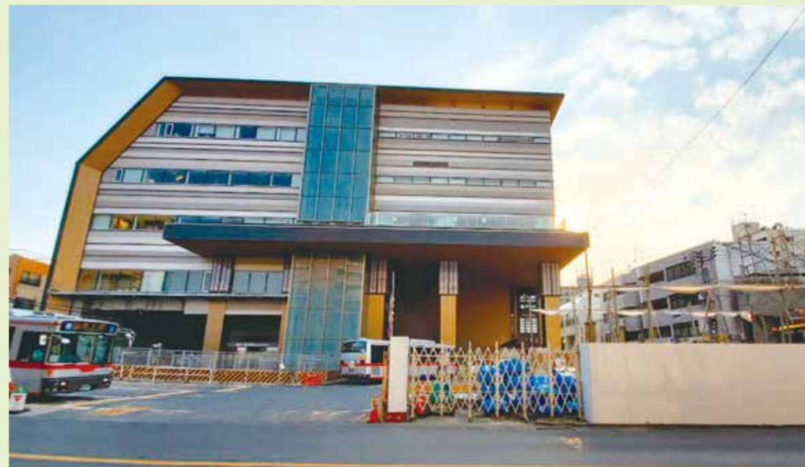
交番の取り壊し工事中
